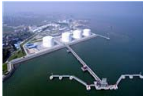
Fujian LNG Terminal
